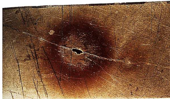
Piqûres sur la paroi d'une cuve en acier inoxydable
